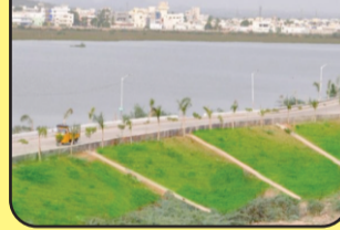
MINI TANK BUND
